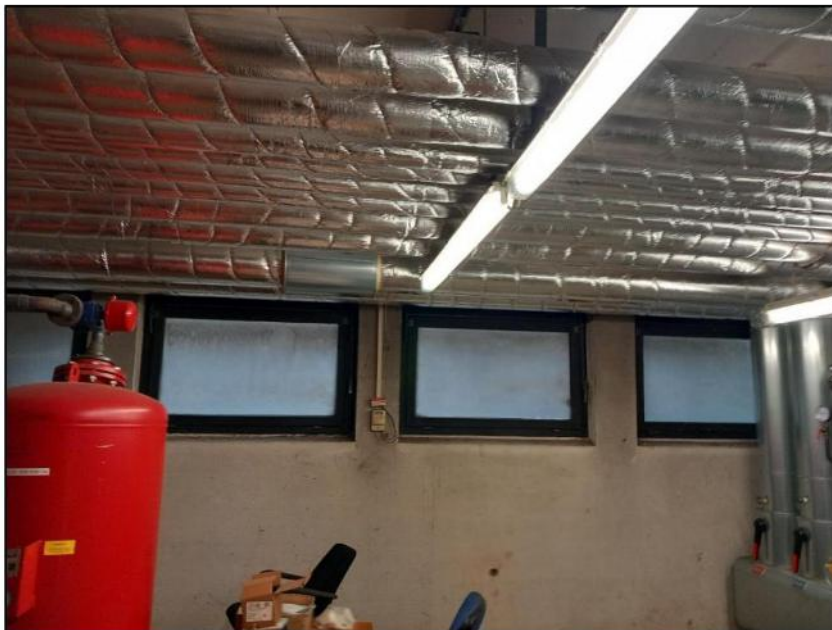
Abbildung 22: Intakte Fenster im Bereich des Heizungskellers.
