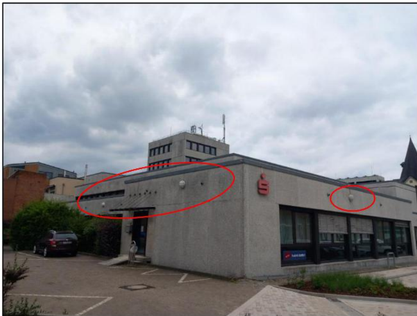
Abbildung 30: Außenbeleuchtung im Parkplatzbereich (Rot).
