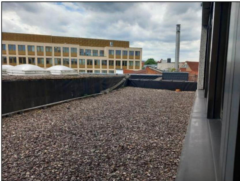
Abbildung 9: Dachfläche zwischen Gebäude Außenfassade und Oberlichtern.
