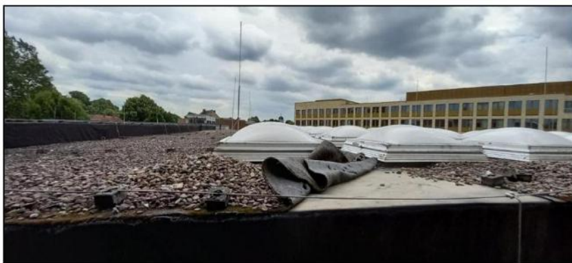
Abbildung 11: Detailaufnahme des Dachbereichs der Oberlichter. Die Oberlichter sind intakt.
