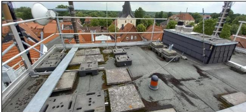
Abbildung 4: Höchste Dachfläche des Gebäudes.
