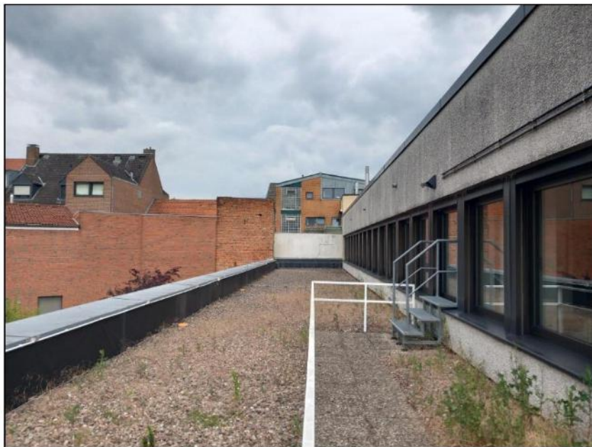
Abbildung 24: Bereich der Dachterrasse.
