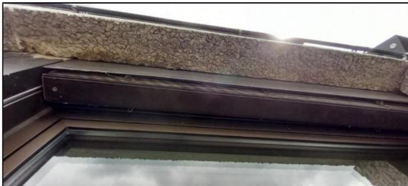
Abbildung 26: Bereich zwischen Fenster und Fassadenplatte.
