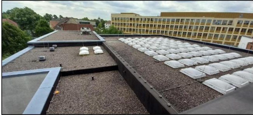
Abbildung 8: Kiesdachbereich mit Oberlichtern.
