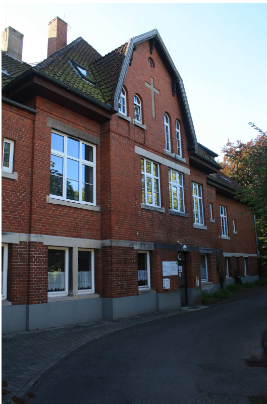
Abbildung 4-1: Blick auf die Vorderfront des alten Verwaltungsgebäudes. Die Mauersegler nisten vermutlich im Dachkasten unter der Regenrinne.
