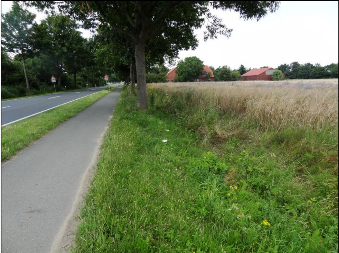
Foto 5: Nienburger Straße (B 442) mit begleitendem Fuß-Radweg, Blickrichtung Nord.
