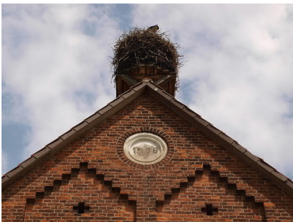
(Ehem.) Alter Werkhof - Gebäude 16: Besetzter Weißstorchhorst (Mai 2021)
