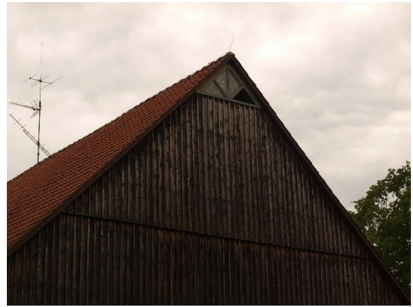
Alter Gutshof Gebäude 33: Dachgiebel (auch von innen untersucht) - ohne Befund (Juni 2021)
