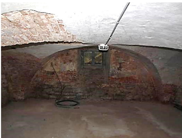
Alter Gutshof, Gebäude 33: Gewölbekeller hermetisch abgeschlossen - ohne Befund (April 2021)
