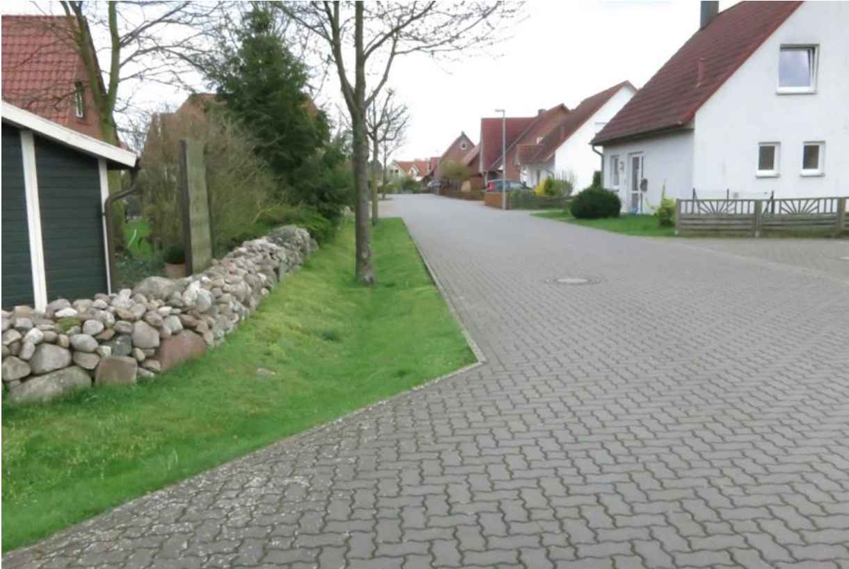
Foto 2: Straßenausbau im Baugebiet 710A mit Sickermulde und Baumpflanzungen
