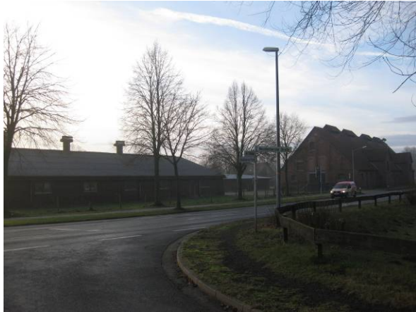
Baukörper des Institutes südlich der Mecklenhorster Straße, Blick Richtung Süden
