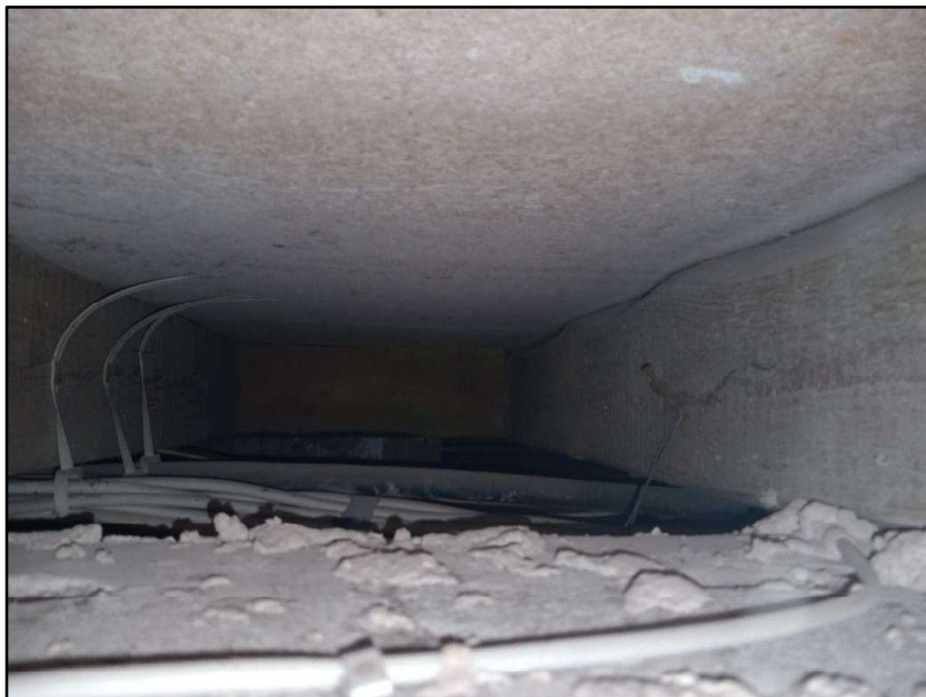
Abbildung 6: Leerer Kabelschacht an der Dachkante (s. Abb. 5).
