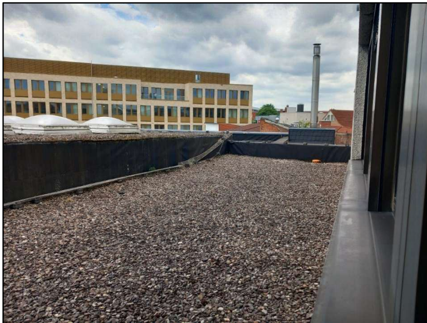
Abbildung 9: Dachfläche zwischen Gebäude Außenfassade und Oberlichtern.
