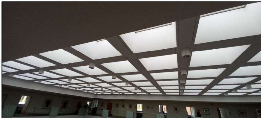
Abbildung 13: Intakte Oberlichter im Foyer.
