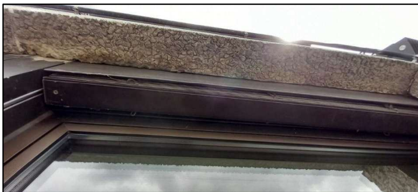
Abbildung 26: Bereich zwischen Fenster und Fassadenplatte.
