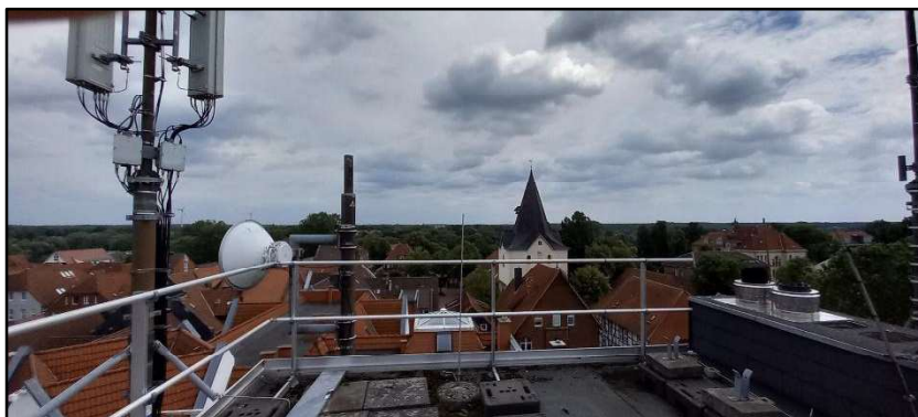
Abbildung 33: Umgebungsbereich des Gebäudes mit Blickrichtung Osten.
