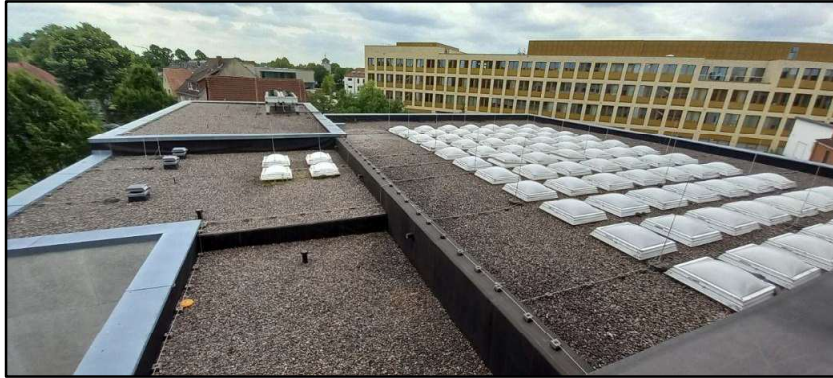
Abbildung 8: Kiesdachbereich mit Oberlichtern.
