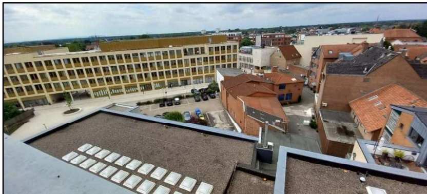
Abbildung 32: Umgebungsbereich des Gebäudes mit Blickrichtung Westen.
