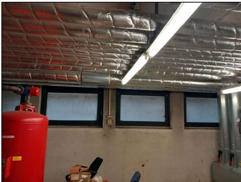
Abbildung 22: Intakte Fenster im Bereich des Heizungskellers.
