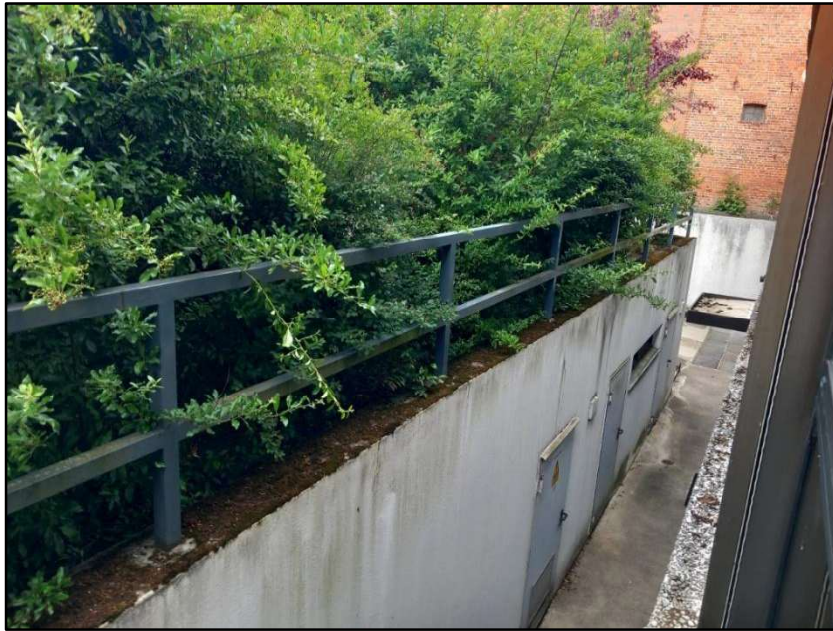
Abbildung 19: Außenzugang zum Kellerbereich.
