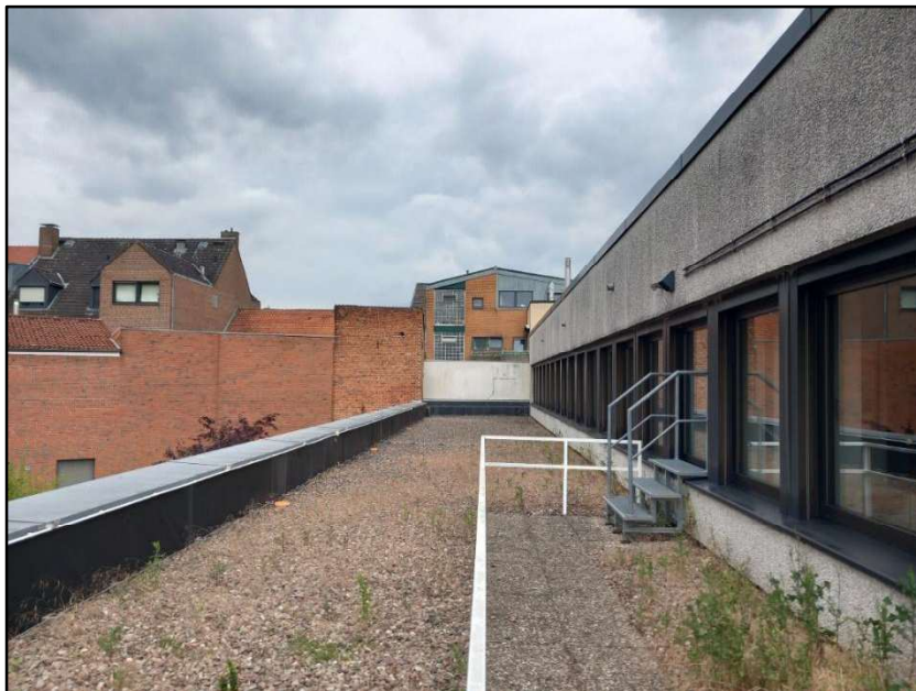
Abbildung 24: Bereich der Dachterrasse.
