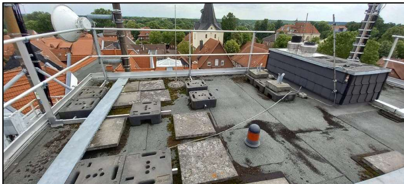
Abbildung 4: Höchste Dachfläche des Gebäudes.
