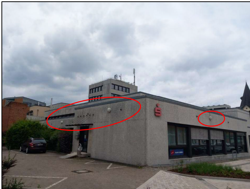
Abbildung 30: Außenbeleuchtung im Parkplatzbereich (Rot).
