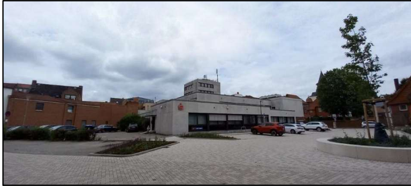
Abbildung 34: Parkplätze südlich an das Gebäude angrenzend.
