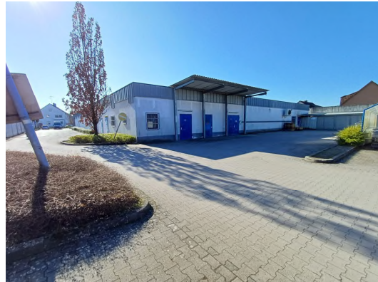
Foto 10: Blick von Hirschberger Straße
