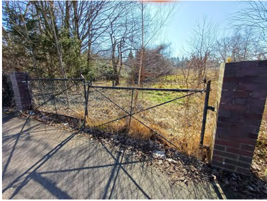
Foto 1: Eingangstor vom Hüttendamm
