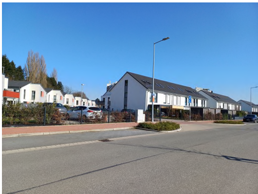
Foto 5: bereits fertiggestellte Wohneinheiten Rittinger Allee
