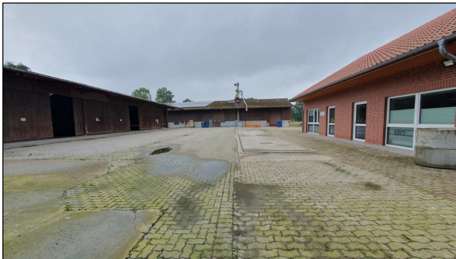
Abb. 11: Lagergebäude (bereits abgetragen) und Wirtschaftsflächen im Plangebiet; rechts das Gebäude der Raiffeisen-Volksbank (eigene Aufnahme, 02.7.2024)
