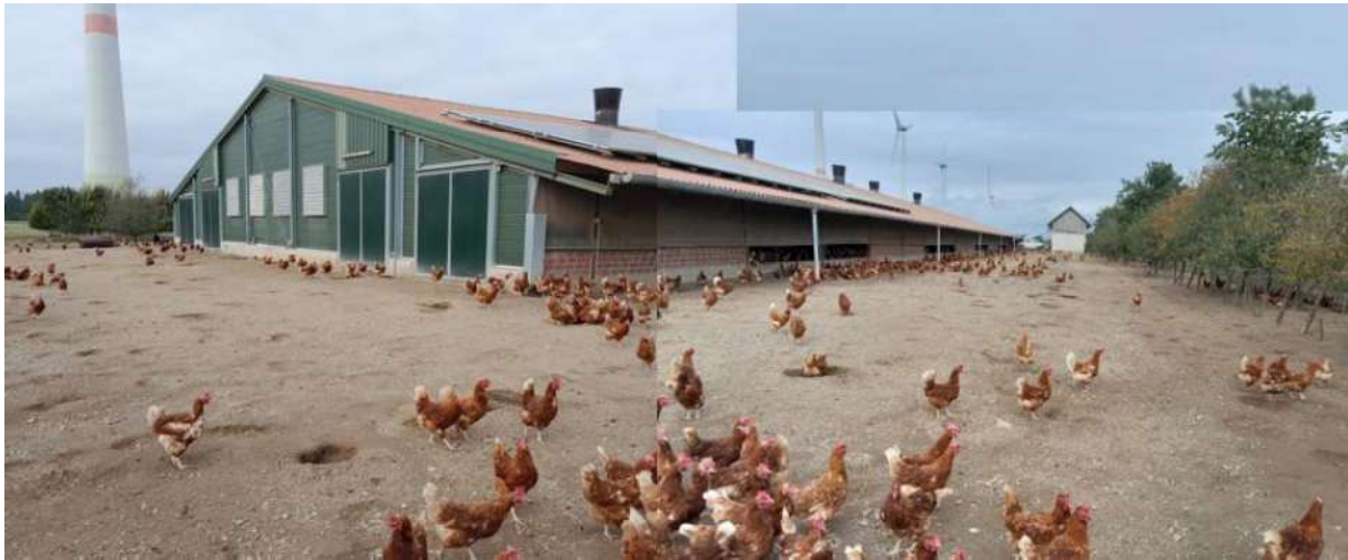
Abb. 3-2: Blick auf die Ostseite des Stallgebäudes
