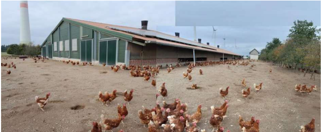
Abb. 3-2: Blick auf die Ostseite des Stallgebäudes
