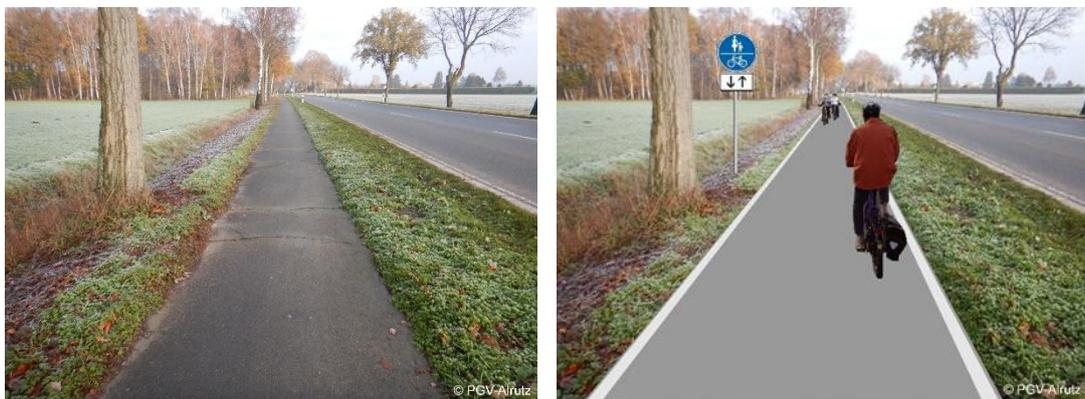
Abb. 4-10: Beispiel für Belagserneuerung inkl. Wegeverbreiterung und Markieren von Randmarkierungen an einer straßenbegleitenden Radverkehrsanlage (Zur Jürse, L 193) (links: Bestandssituation, rechts: Fotomontage)
