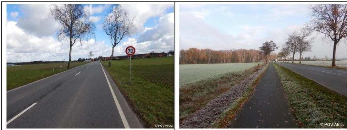
Abb. 2-1: Mischverkehrsführung im Zuge Evensener Straße (L 191) (links) sowie gemeinsamer Geh- und Radweg in unzureichender Breite und Zweirichtungsführung im Zuge Zur Jürse (L 193) (rechts).
