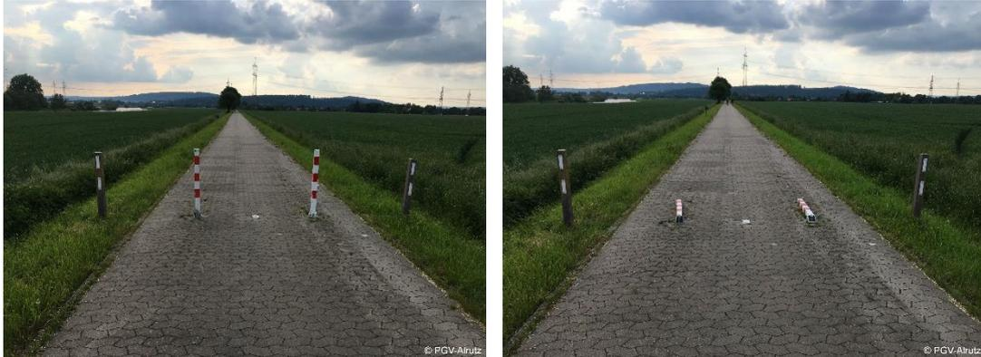
Abb. 4-15: Umklappbare Poller in hoch- und runtergeklapptem Zustand (Weserradweg, bei Hameln)
