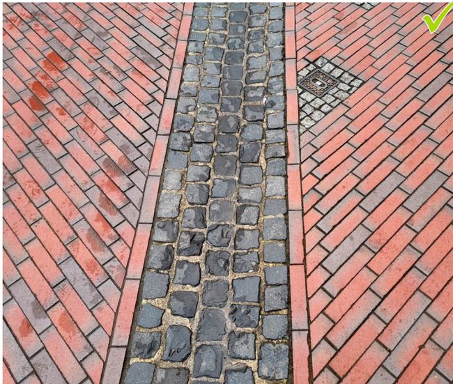
Abb. 31: Bockhorner Klinkerriegel mit Basaltgasse
