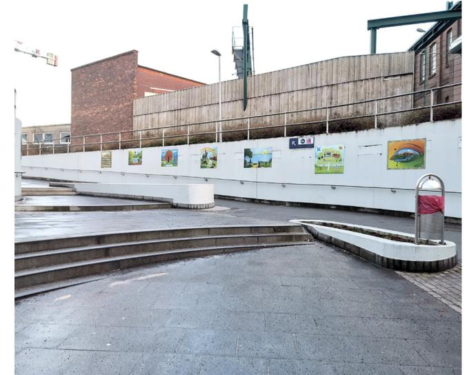
Abb. 171: Integration von Rampen an Stufenanlagen
