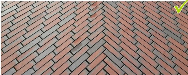
Abb. 32: Diagonal-Verband mit Naht
