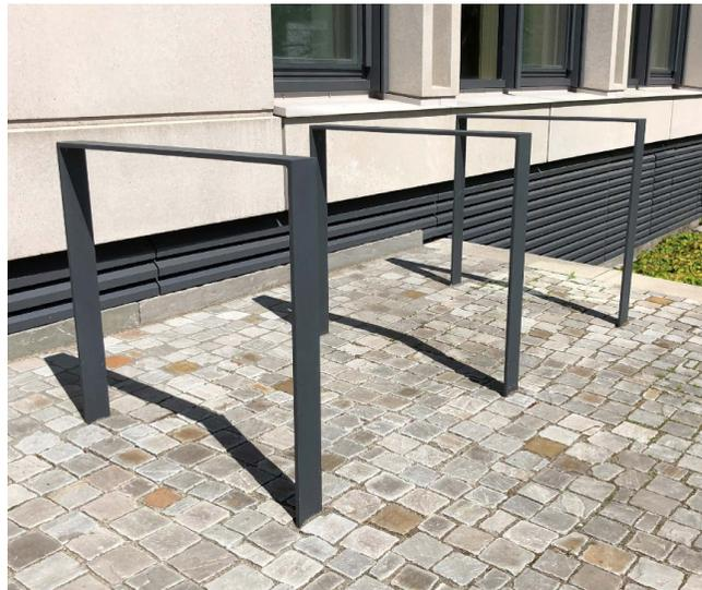
Abb. 99: Flachstahl-Fahrradbügel
