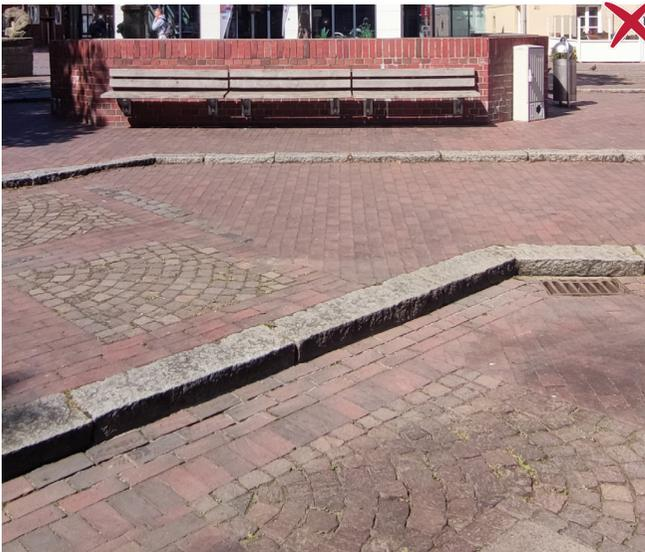
Abb. 54: Klinkerpfaster und Kopfsteinpfaster mit Stufen
