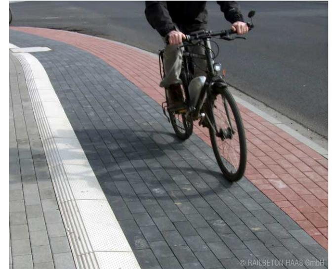
Abb. 163: Roter und dunkler Pflasterstein im Läuferverband
