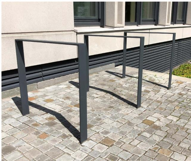
Abb. 108: Flachstahl-Fahrradbügel
