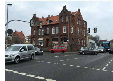
Abb. 80 (links): schwierige Verkehrsführung an der Zufahrt Nienburger Straße 3
