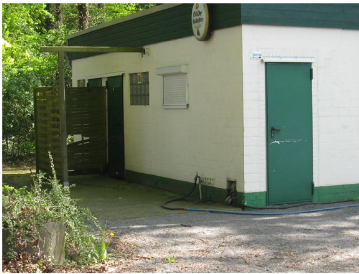
Infrastruktur: Eingang Toilettenbereich
