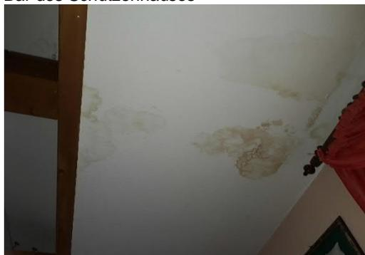
Wasserschaden durch undichte Dachstellen
