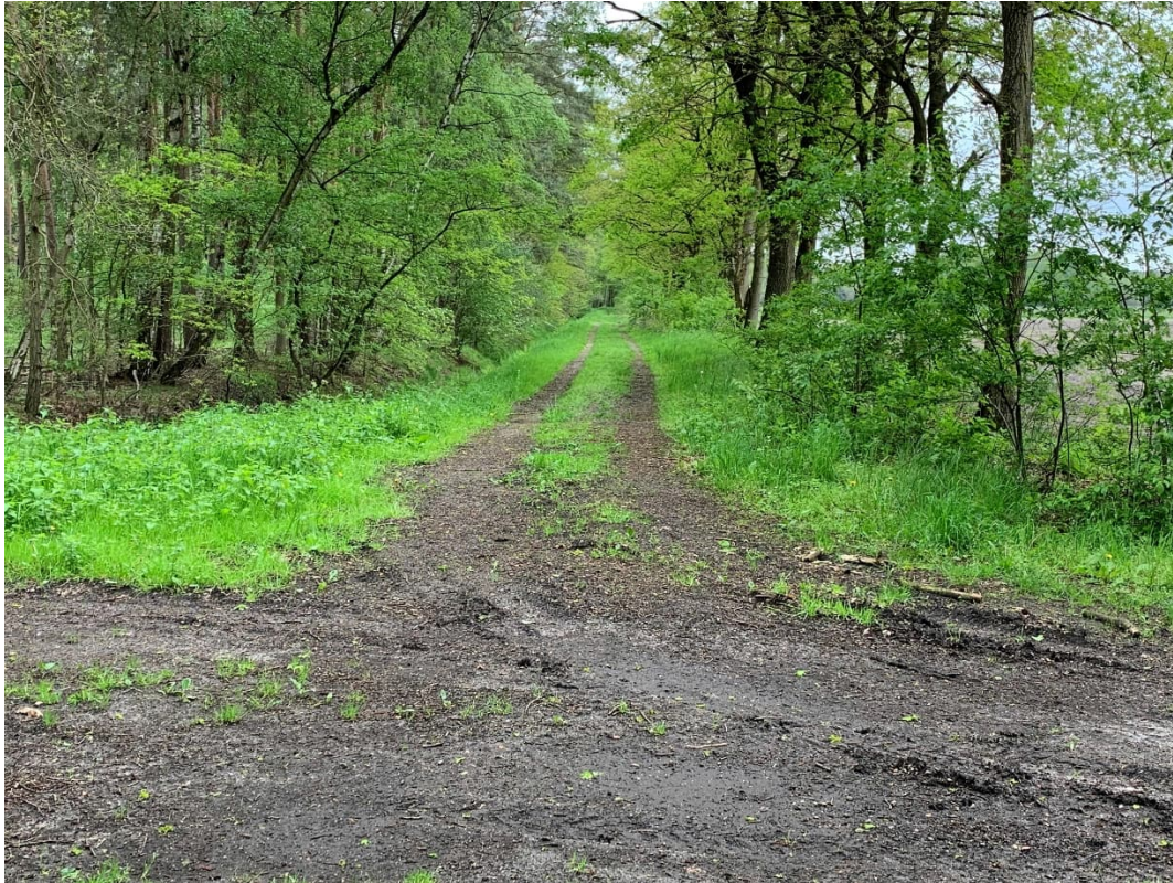
Radweg (derzeitiger Zustand) von Beginn von Osten her
