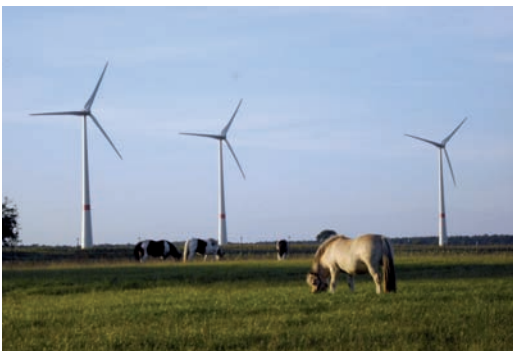
Windkraftstandort in Wulfelade nach Repowering.
