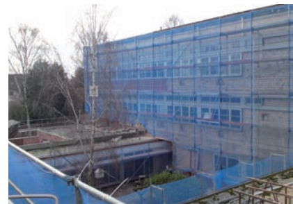
Energetische Sanierung der Hans-Böckler-Schule.
