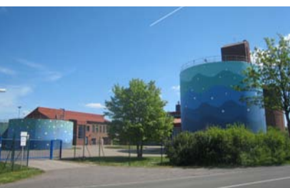
Auf der größten Kläranlage Neustadts in Empede wird seit 2009 ein Blockheizkraftwerk zur Klärgas-Verstromung betrieben.
